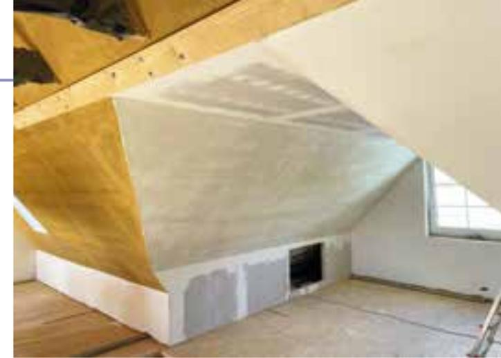
Lehmwände vor und nach der ersten Beschichtung. Die Öffnung in den Abseiten wurden mit OSB- und GKF-Platten ausgekleidet.
